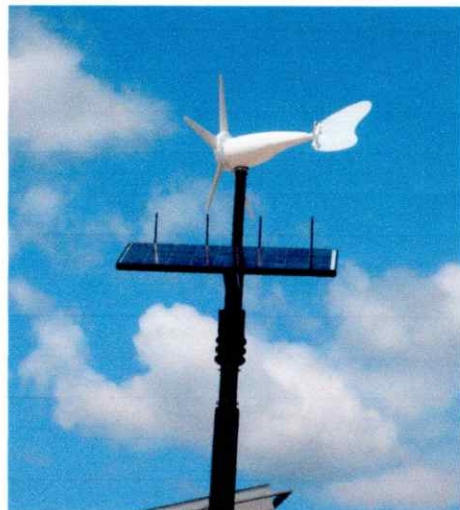
平成19年度 ハイブリッド照明灯 (総合運動公園)
